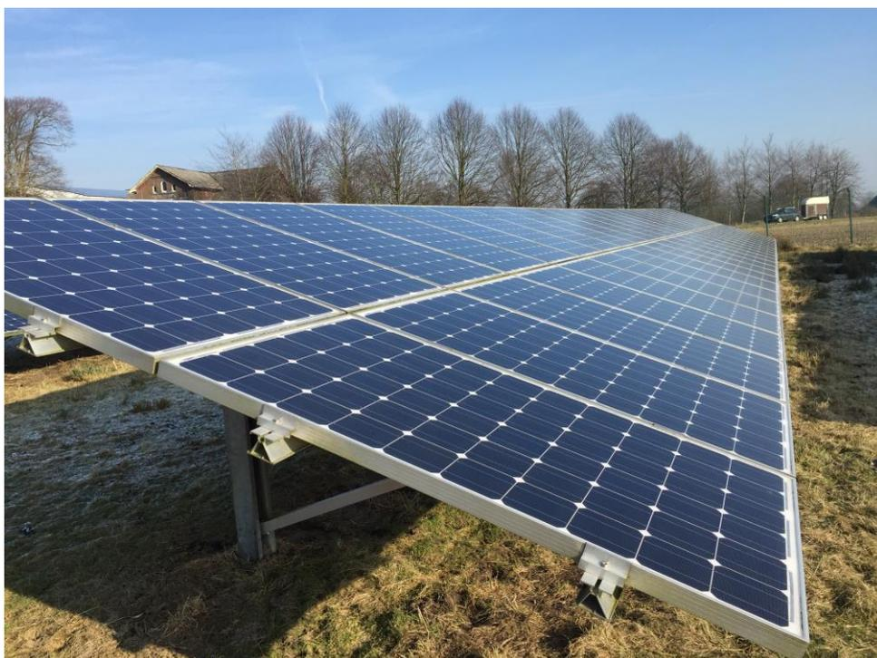
**Abbildung 3:** Beispiel einer PV-Freiflächenanlage mit 2 senkrechten Modulreihen
